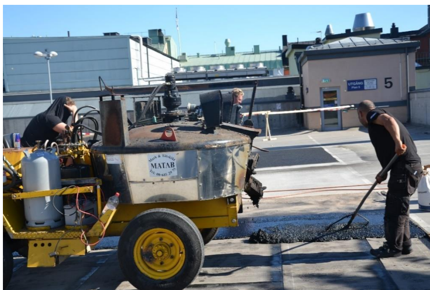
Utläggning av gjutasfalt på tätskiktsmatta (provläggning på P-däck i betong, Baggen 2015)
